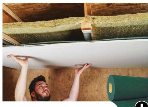
Fermer la partie inférieure du plancher en appliquant une couche résiliente **PIANO A**, **SILENT UNDERFLOOR**, **GEMINI**, **GIPS BAND CONSTRUCTION SEALING** sur les solives et ajouter une masse à la plaque en placo-plâtre avec **SILENT WALL BYTUM** ou **SILENT WALL BYTUM SA**
